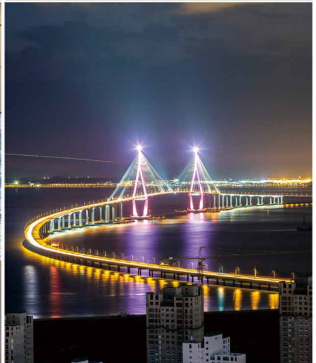
시민편의 중심 국제도시 기반시설 조성
